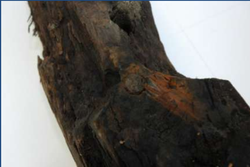
Passages de gournables et broche sur membrure
