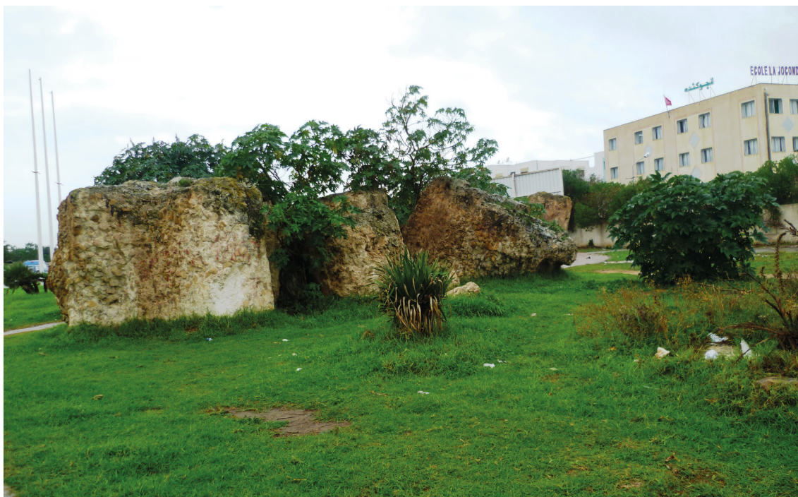
Fig. 4 : Vestiges de l'aqueduc à Dar Fadhal, La Soukra.
