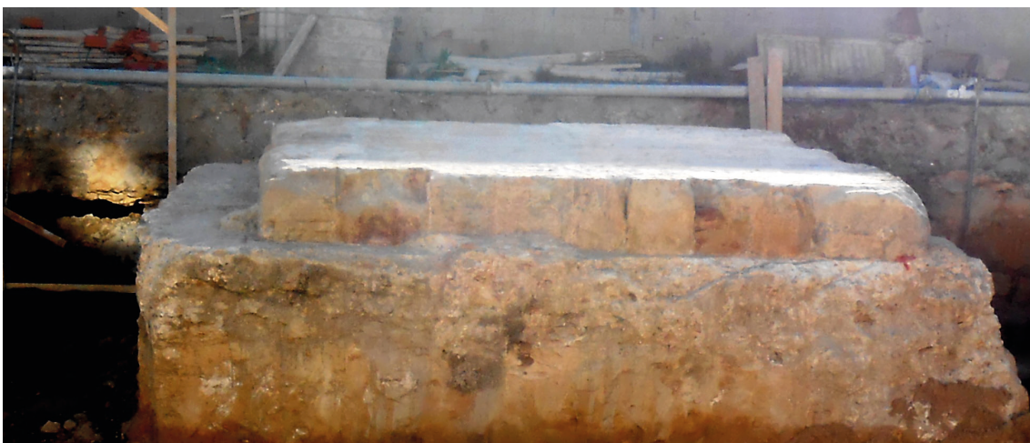
Fig. 10 : Base en blocage et la première assise du pilier. © M. Adili
