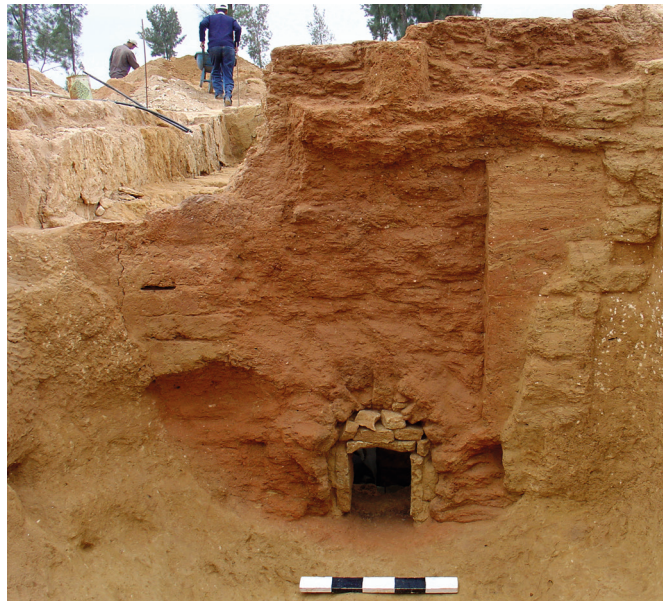
Fig. 24 : Façade nord : le parement est seulement conservé à droite ; un témoin du comblement pluvial conforte la paroi très dégradée (cliché J. Thiriot).
