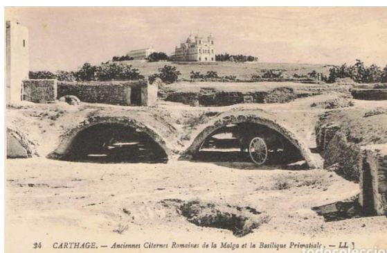
Fig. 2 : Les citernes de la Maalga.
