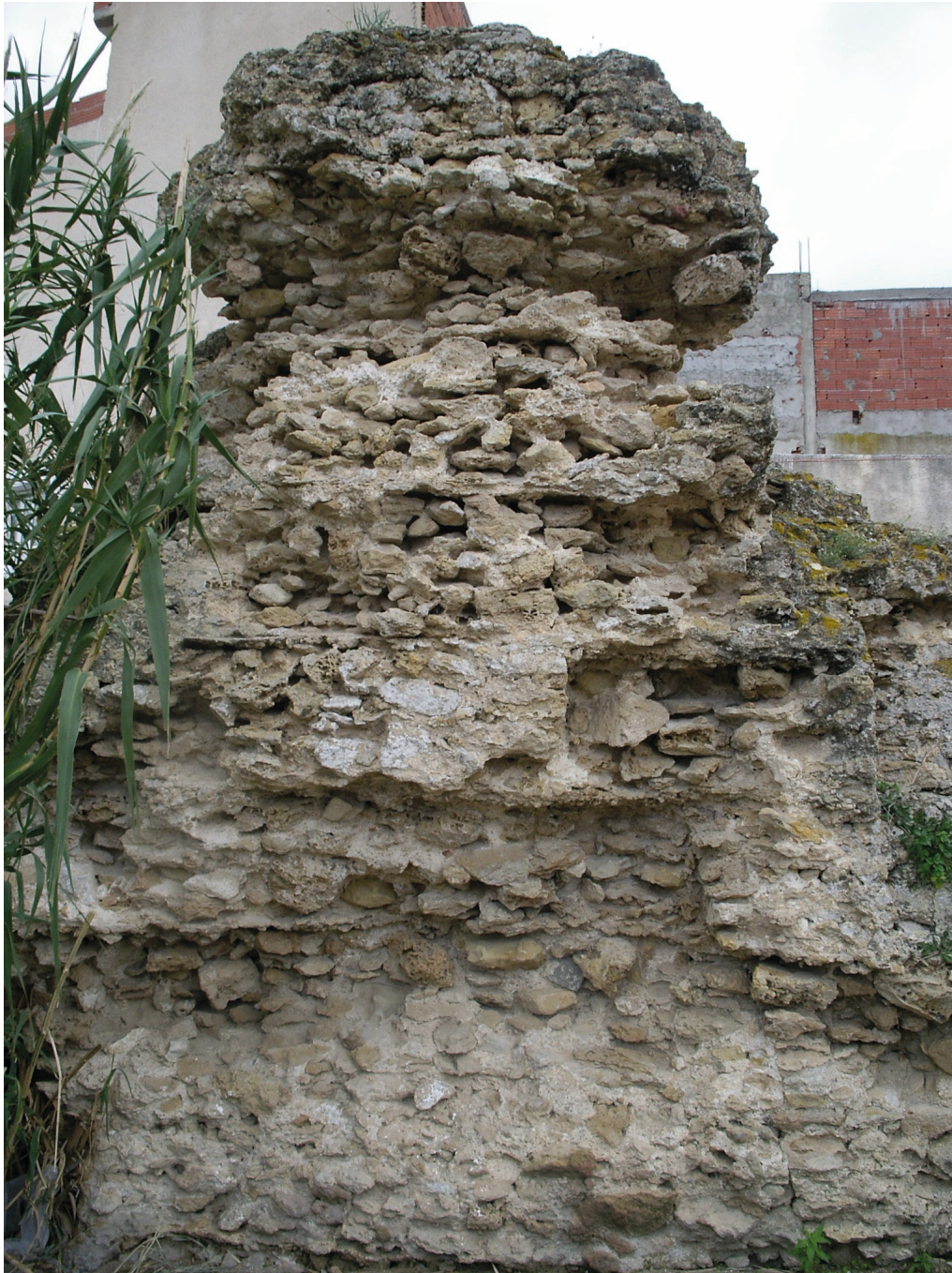
Fig. 16 : Blocage banché en stratigraphie.
