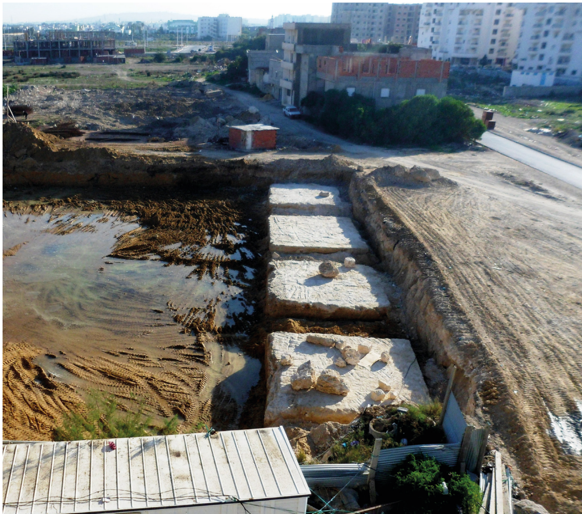
Fig. 13- Bases des piliers découvertes dans le sondage n°3.
